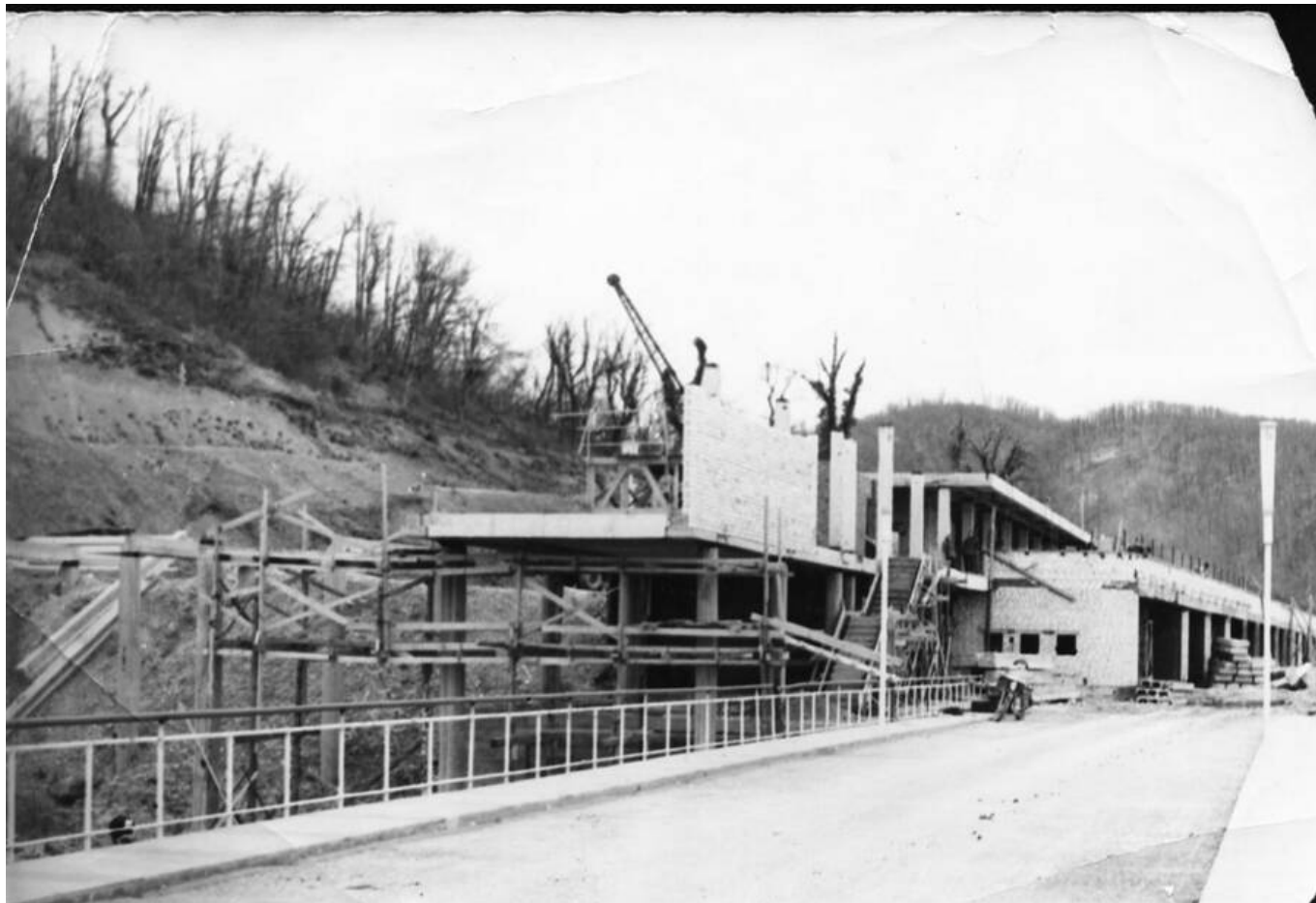
Строительство лагеря. Монтаж средней палубы.
